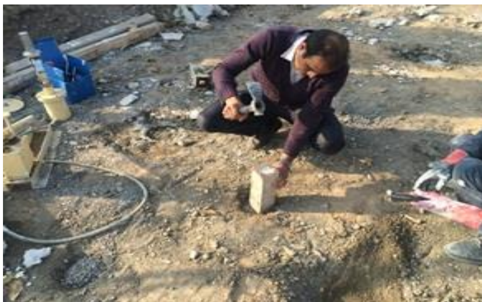
شکل (۷) نحوه متراکم کردن مصالح درون ستون‌ها
